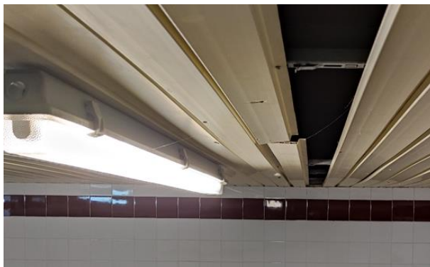
Falç sostre existent i estat de conservació
