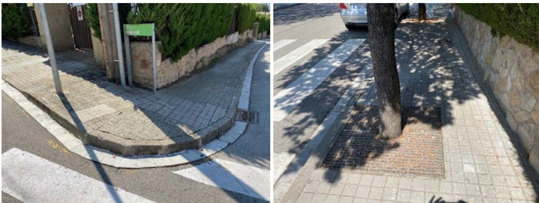
Vista a les voreres
