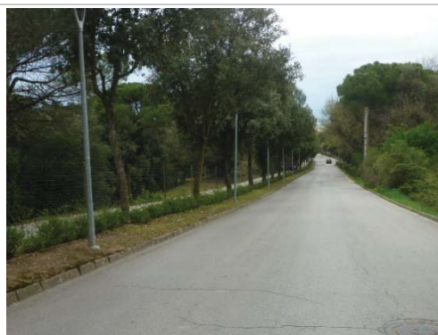
Imatge 143. Vista de la baixada, amb vorera i mitjana.
