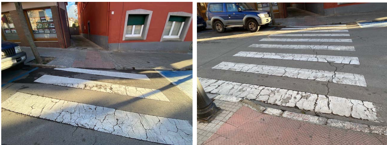
Vista al pas de vianants actual
