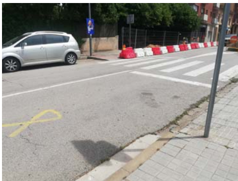
Vista al pas de vianants actual
