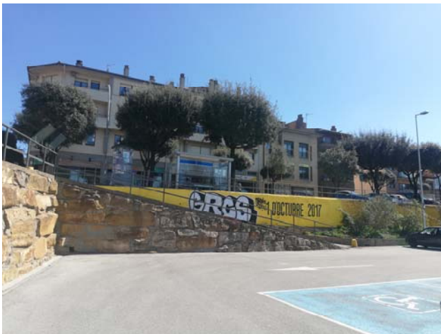
Vista de la rampa d'accés a l'aparcament
