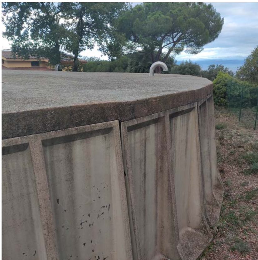
Imatge 2: Paraments verticals prefabricats i coberta exterior del dipòsit
