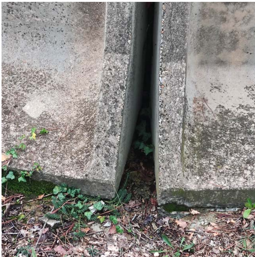
Imatge 3: Junta dels paraments verticals prefabricats
