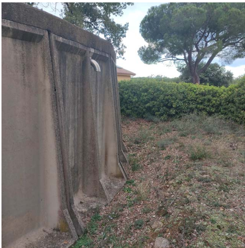
Imatge 1: Paraments verticals prefabricats exteriors del dipòsit
