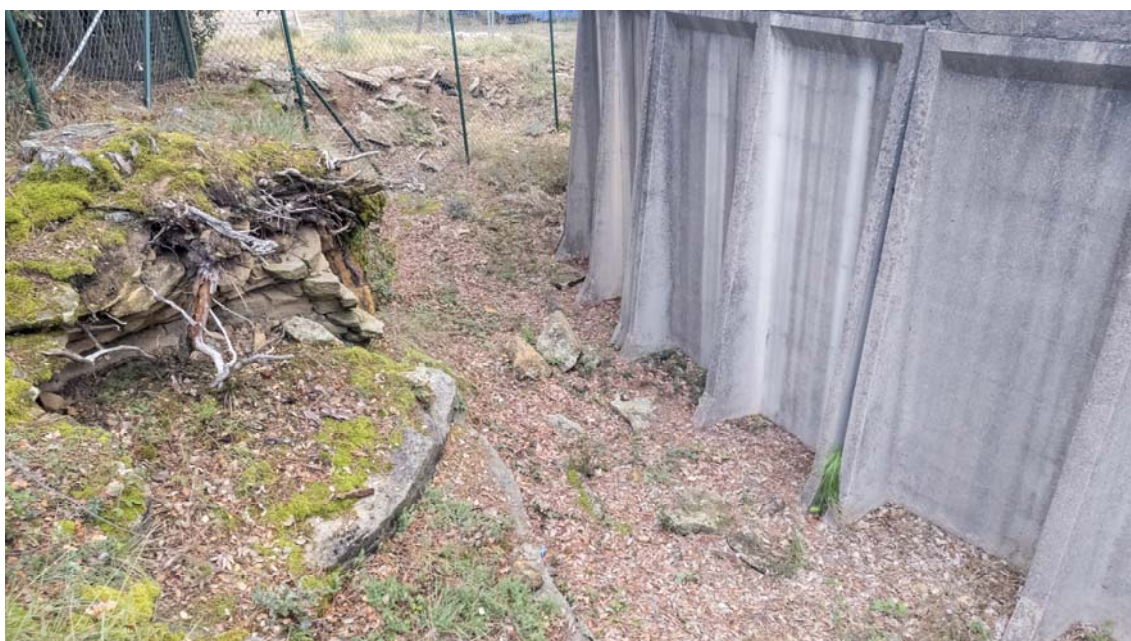
Imatge 8: Paraments verticals prefabricats exteriors del dipòsit
