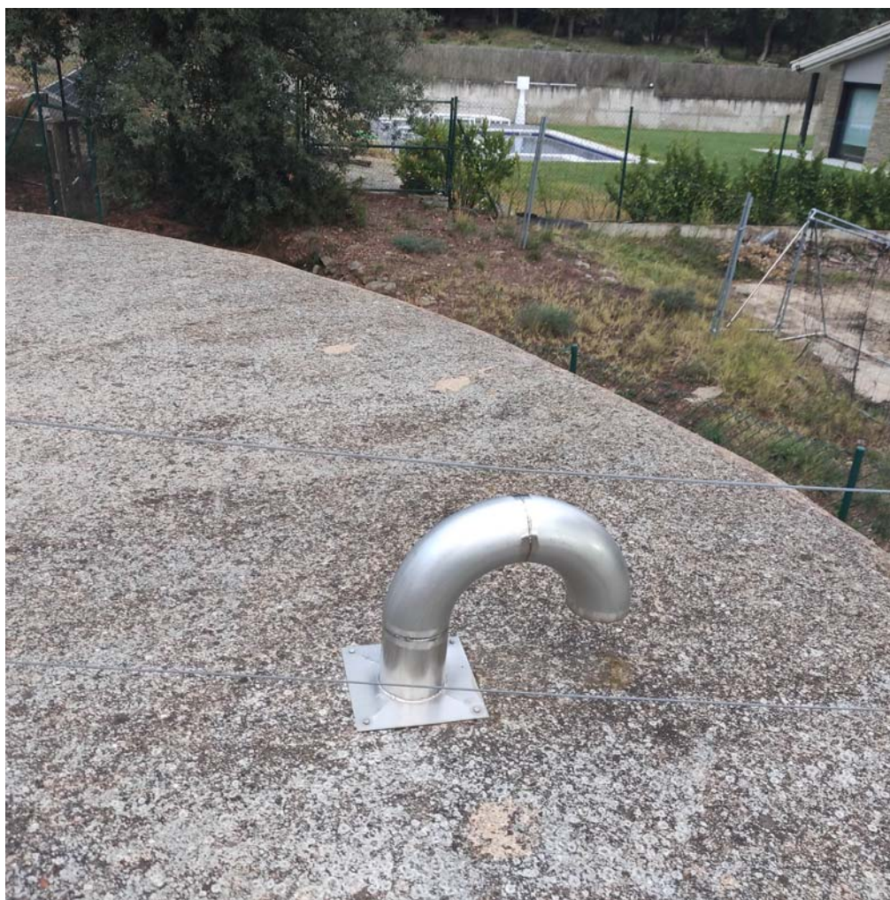
Imatge 6: Coberta exterior i tub de ventilació
