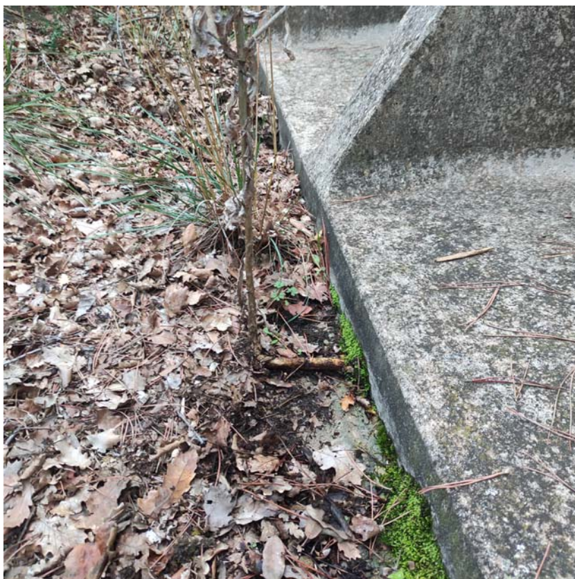
Imatge 1: Paraments verticals prefabricats exteriors del dipòsit
