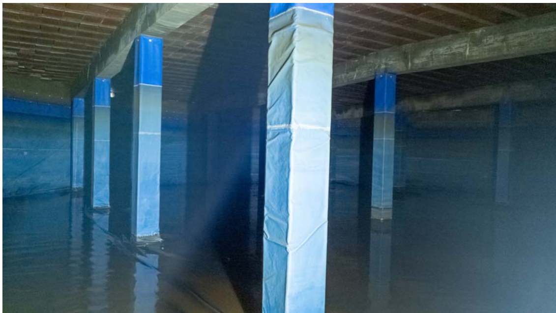
Imatge 5: Perspectiva interior dipòsit – lona a retirar
