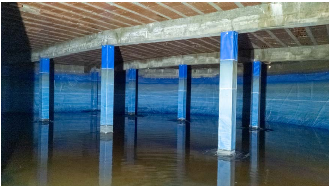
Imatge 4: Perspectiva interior dipòsit – lona a retirar
